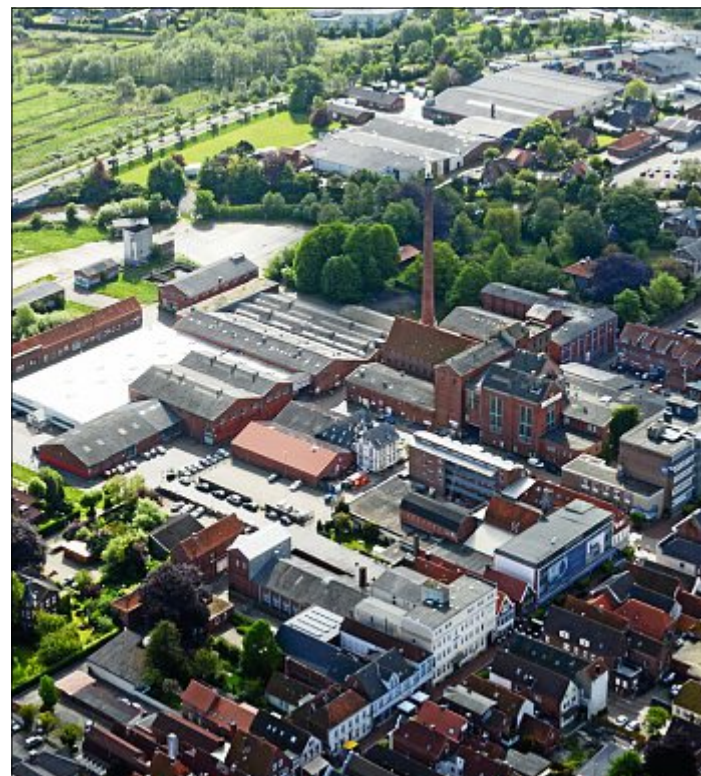
Der Schornstein am Kessel- und Maschinenhaus der früheren Doornkaatbrennerei ist ein zentrales Bauwerk. FOTO: STROMANN
