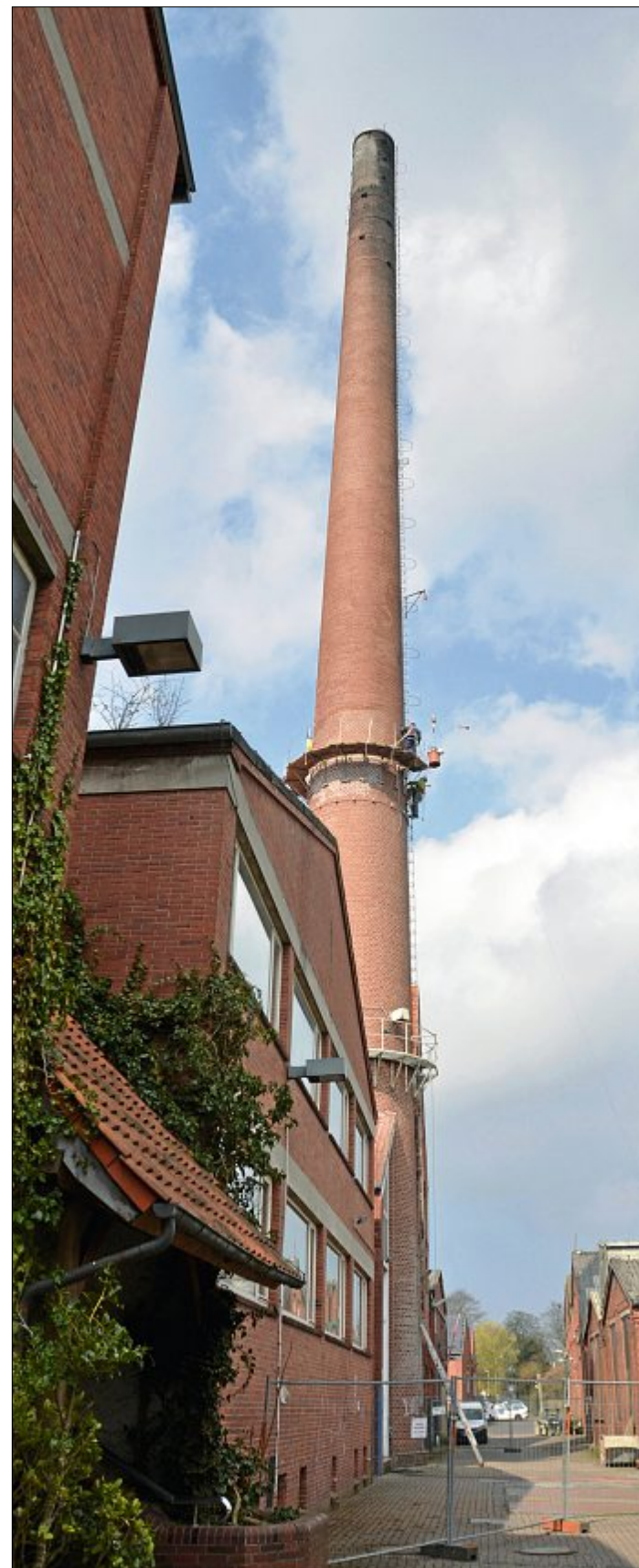
Der Schornstein auf dem ehemaligen Doornkaat-Gelände wird bald um zehn Meter kürzer sein. FOTO: PRIVAT
